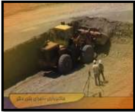
خاکبرداری و اجرای بتن مگر
