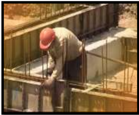
قالب بندی فونداسیون
