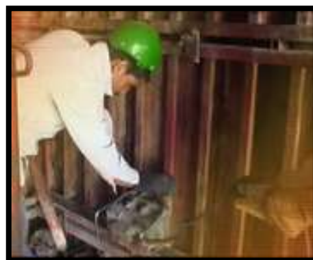
ویبره بتن توسط ویبره متصل به قالب ها
