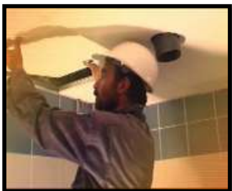
استفاده از پانل های گچی جهت سقف سرویس ها
