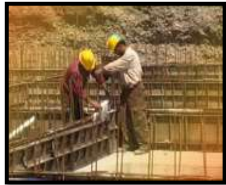
قرار دادن پلاستوفوم پیش از بتن ریزی در محل تقاطع لوله های تأسیساتی
