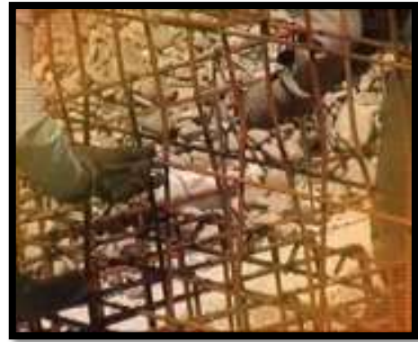
عملیات آرماتوربندی فونداسیون و پدستال
