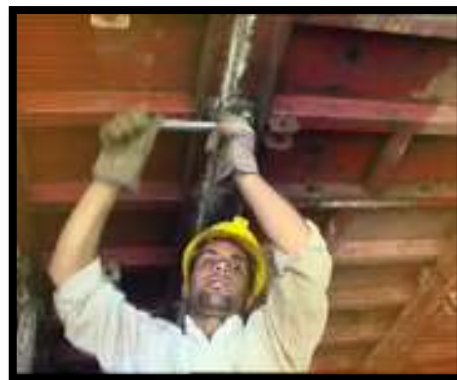
مهاری بندی قالب ها
