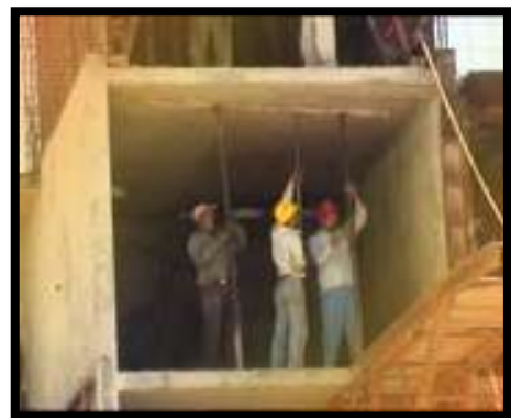
مهار قالب ها در هنگام دپو
