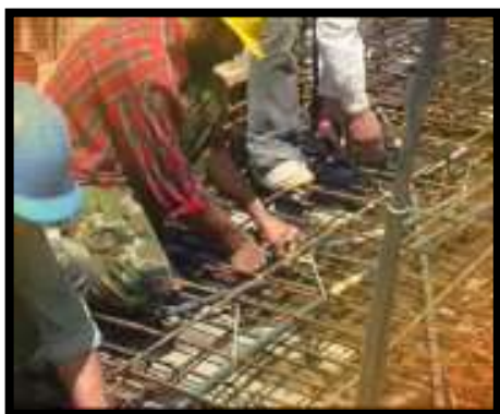
پیش بینی قالب بندی تأسیساتی در سقف
