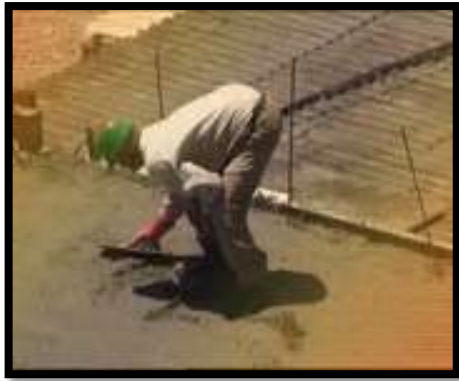
عملیات ماله کشی و مسطح کردن سقف با ماله دستی یا برقی
