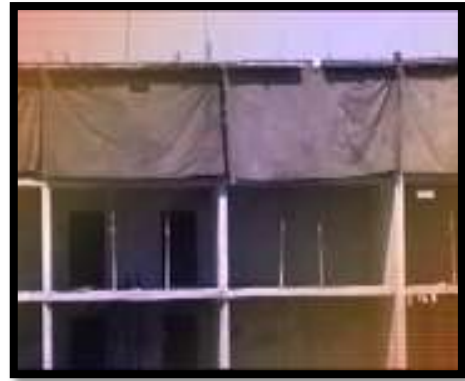
مسدود کردن دهانه تونل ها توسط برزنت جهت عمل آوری بتن در فصل سرما
