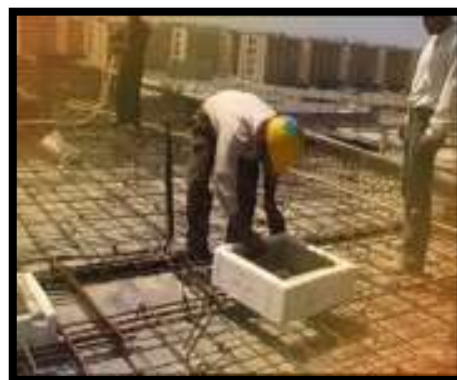
قالب بندی داکت ها قبل از بتن ریزی
