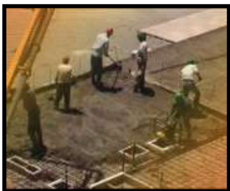
عملیات بتن ریزی در سقف
