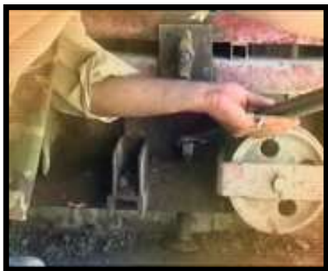
تنظیم قالب ها تا ارتفاع مورد نظر توسط جک های زیر قالب
