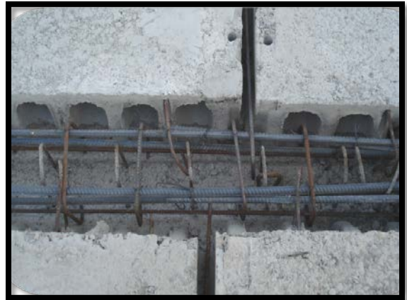
اتصال سقف به سقف بدون بتن رویی
