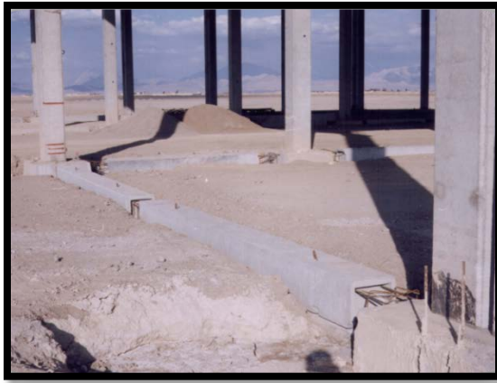
تصویری از فونداسیون های پیش ساخته همراه با شناژ
