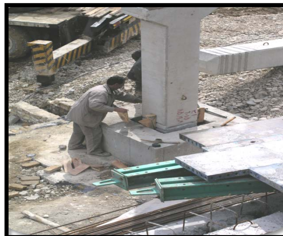
اتصال ستون به فونداسیون در جا با اتصال گلدانی
