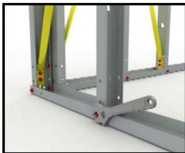
محکم کردن اتصالات پیچ و مهره ای
