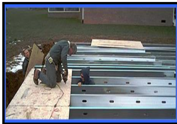
نحوه اجرای runer کف
