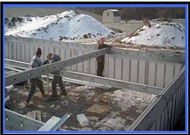
نحوه اجرای پروفیل های کف
