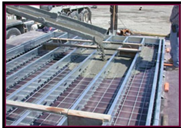
نحوه بتن ریزی قطعات در کارگاه
