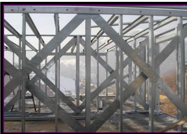
نحوه اجرای دیوار برشی
