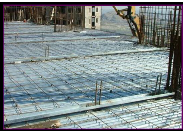
نحوه اجرای سقف با ورق های کرکره ای و بتن
