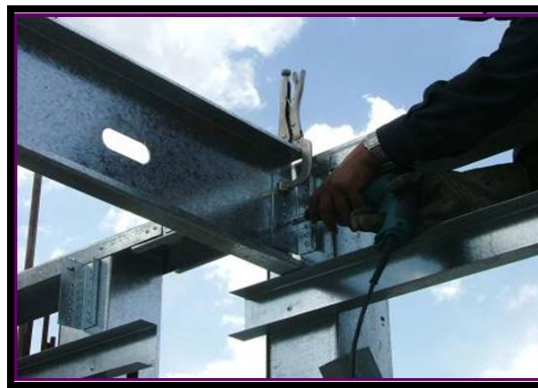
نحوه اتصال joint به سازه باربر
