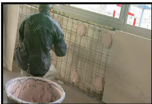
آماده سازی دیوار جهت نصب گچ برگ
