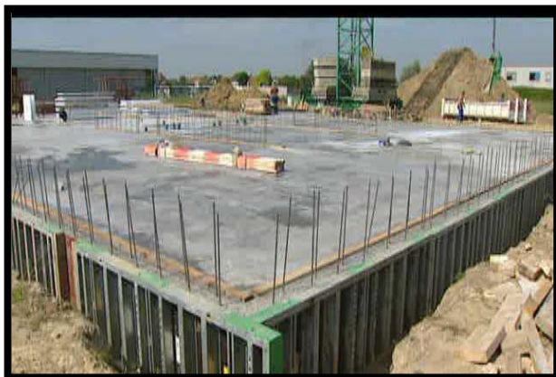
نمایش آرماتور انتظار دیوارها
