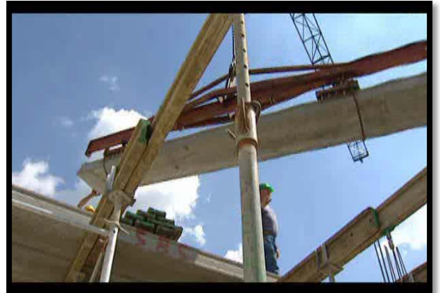
نحوه جابجایی پانلهای سقف جهت نصب
