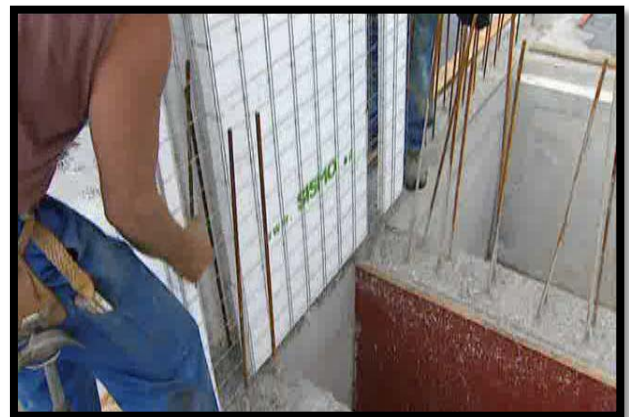
اتصال دیوارها به کف
