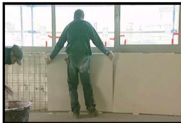
نحوه نصب گچ برگ دیوار
