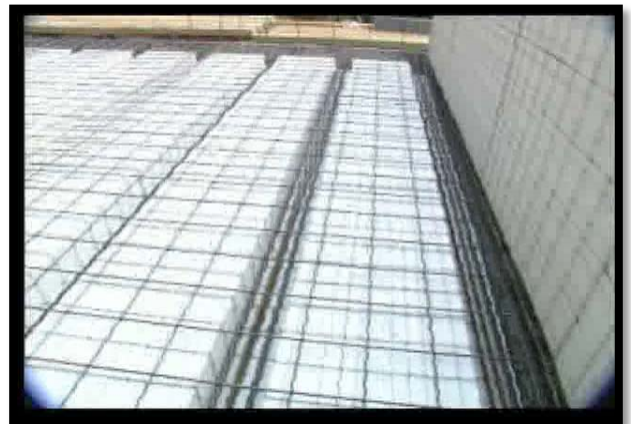
نحوه نمایش اجرای سقف از دید بام
