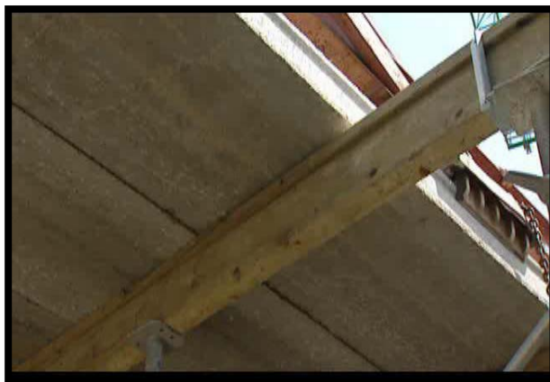
نحوه نمایش اجرای سقف از دید داخل ساختمان
