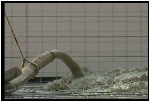
نحوه بتن ریزی بام
